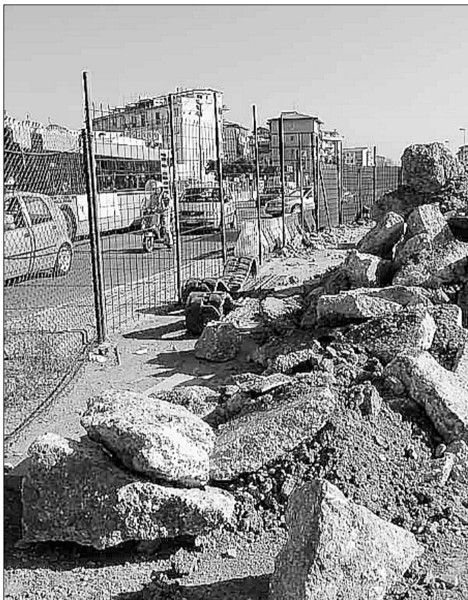
Cantieri per la tramvia aperti sulla direttrice viale Talenti-via del Sansovino
